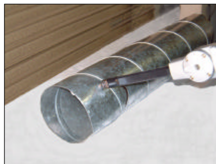
スパイラルダクトの切断
